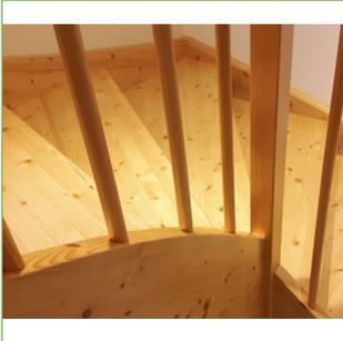
Gestemte Massivholzwangentreppe aus Fichtenholz stabverleimt mit Tritt- und Setzstufen von EG in OG
